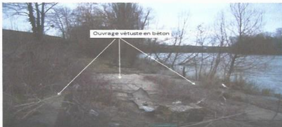
Document 1 . Etat actuel du site avant les travaux
